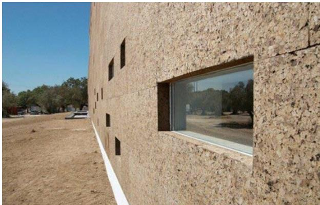
Slike 48-50. Prikaz proizvoda i konstrukcija od termoizolacionih plutanih ploča (izvor: [www.buildinggreen.com](http://www.buildinggreen.com), [www.amorimcorkinsulation.com](http://www.amorimcorkinsulation.com))
