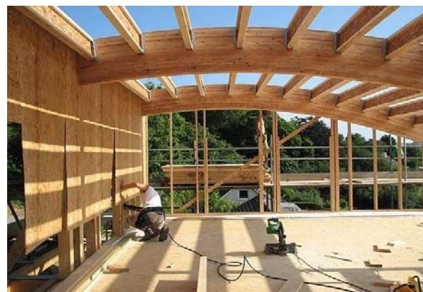
Slika. 8 – Krovne grede montirane na licu mesta od prefabrikovanih elemenata ([www.usframing.com](http://www.usframing.com))
