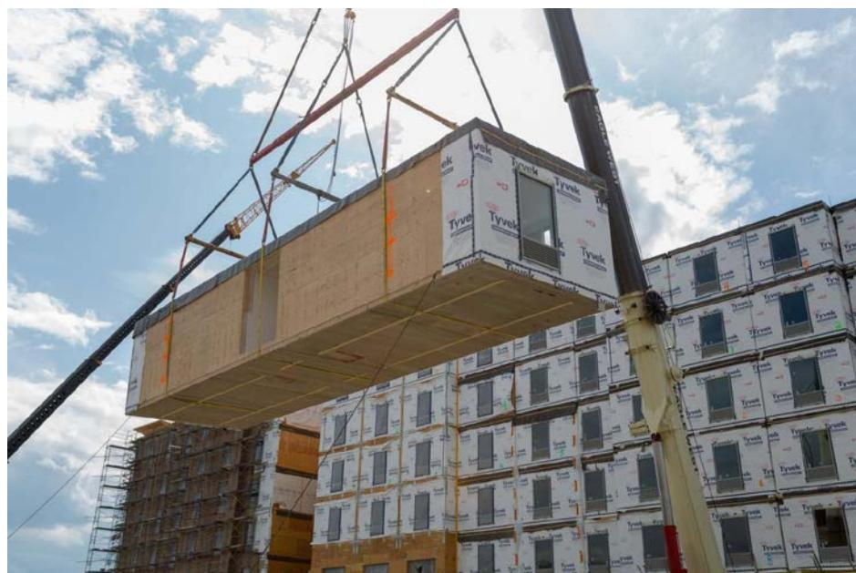
Slika 7. Tipična montažna modularna jedinica sa pristupom „ključ u ruke“
