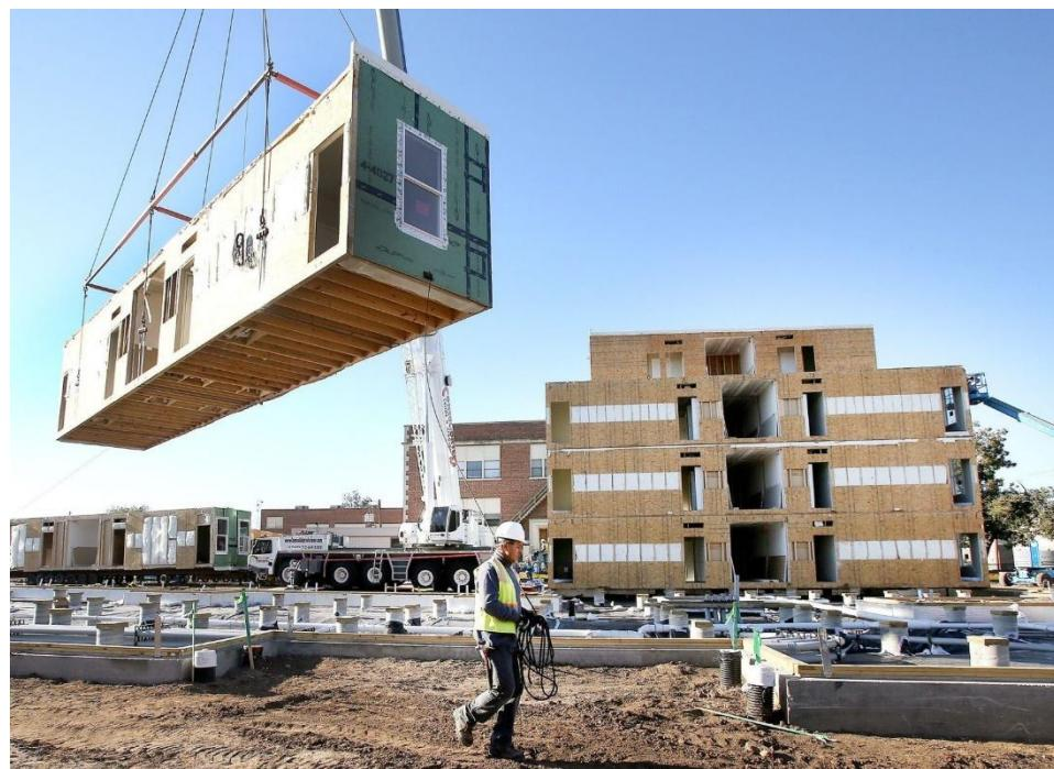
Слика 11. Трајна модуларна конструкција
